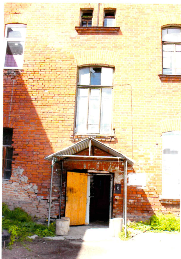
Видовая точка № 13. Лучковый проем дворового входа. Дворовая часть южного фасада.
