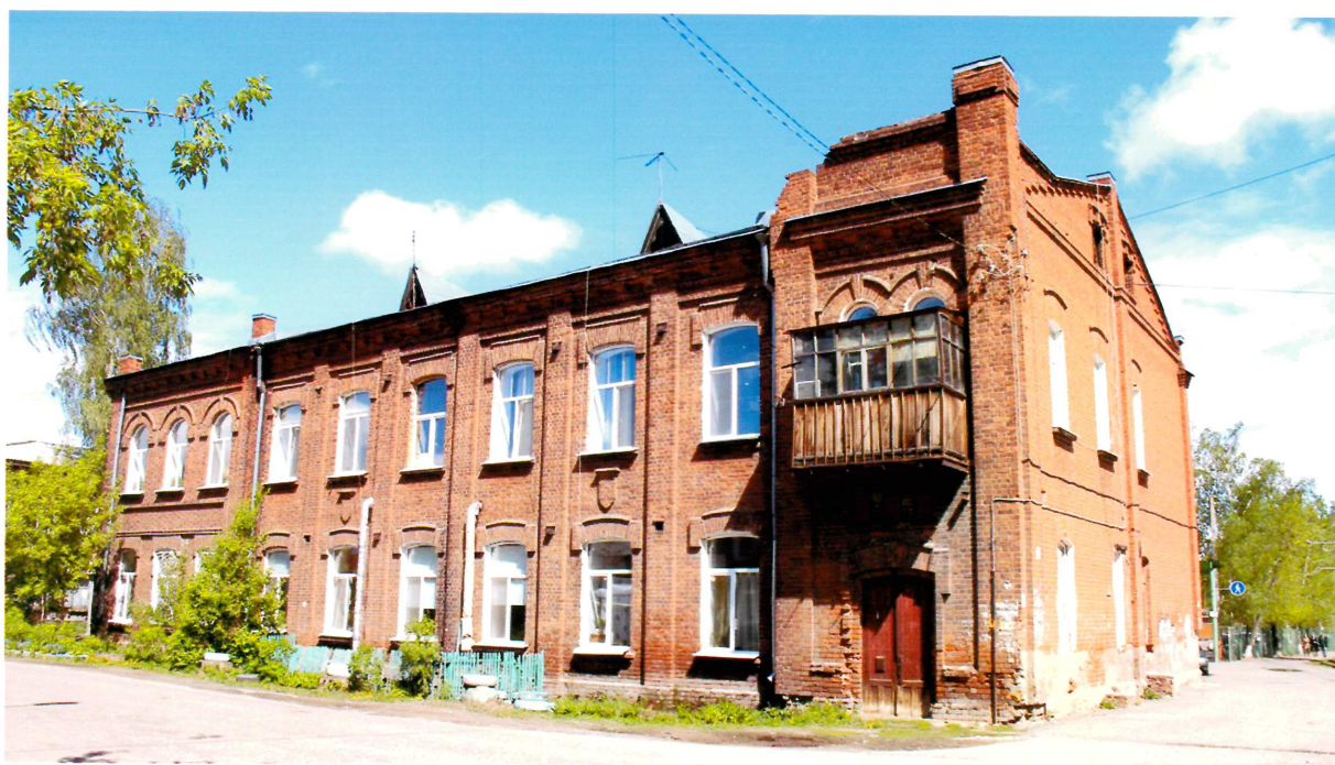
Видовая точка № 1. Западный фасад здания. Вид с ул. Гоголя.
