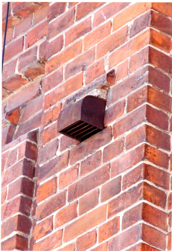
Видовая точка № 15. Выносной металлический короб междуэтажного продуха.
