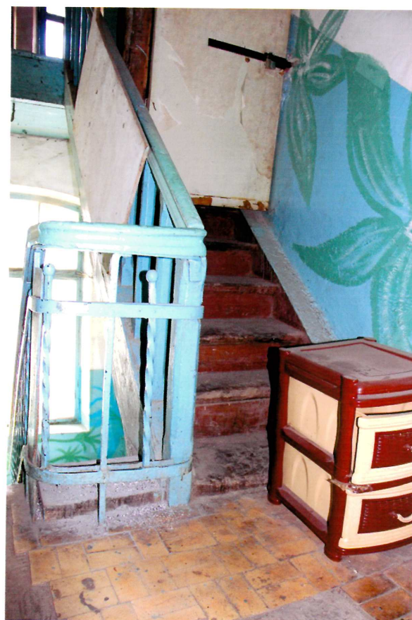
Видовая точка № 22. Деревянная лестница северной части здания в уровне, ведущая на чердак.
