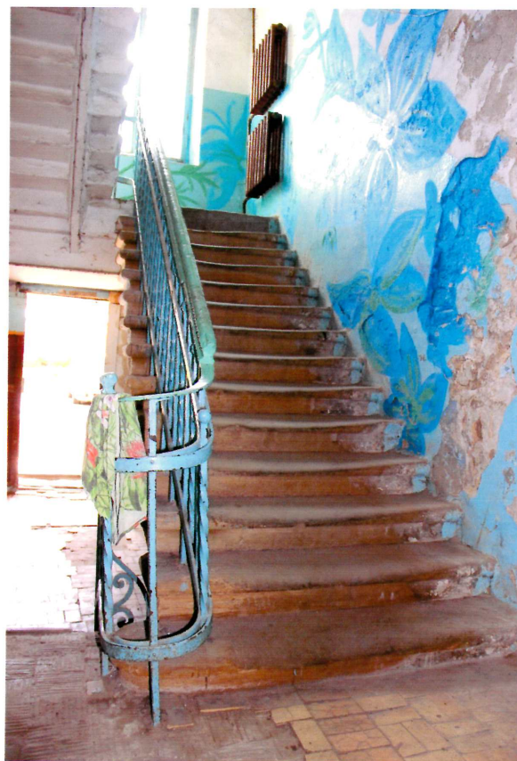
Видовая точка № 20. Интерьер лестничной клетки северной части здания в уровне 1-го этажа.
