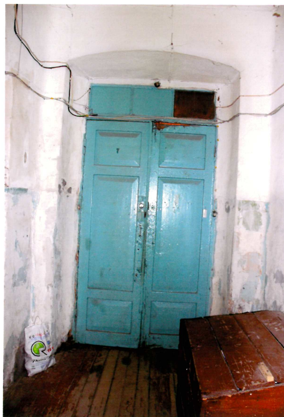
Видовая точка № 16. Лучковый проем для двухстворчатой прямоугольной двери с фрамугой. 1-й этаж.
