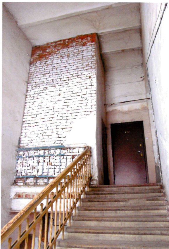
Видовая точка № 19. Интерьер лестничной клетки южной части здания. Фрагмент потолка (своды по металлическим балкам).
