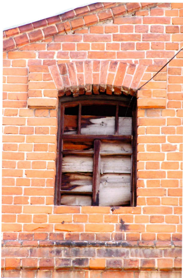
Видовая точка № 11. Лучковое слуховое окно. Торец восточного фасада.
