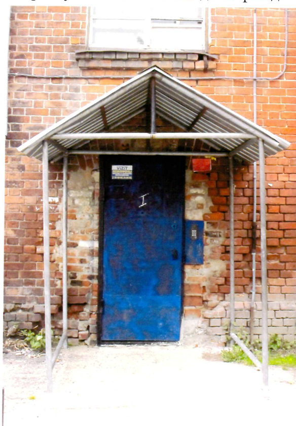
Видовая точка № 14. Проем дворового входа. Дворовая часть восточного фасада.
