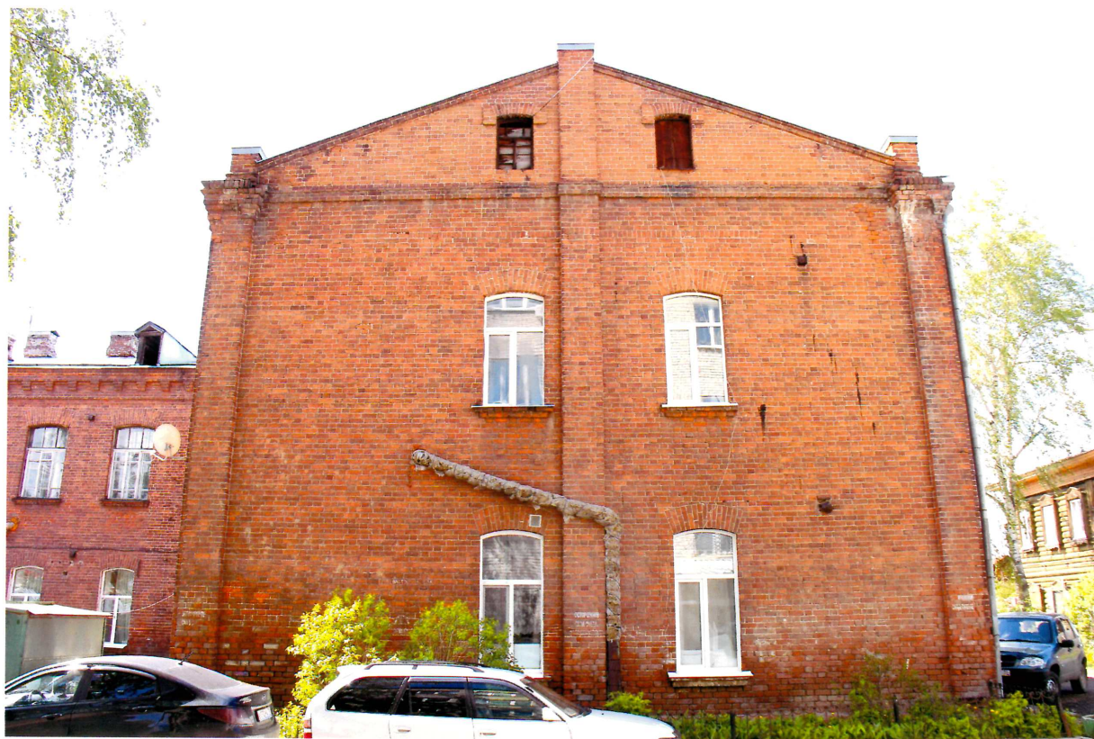
Видовая точка № 4. Торцев восточного фасада. Вид со двора.
