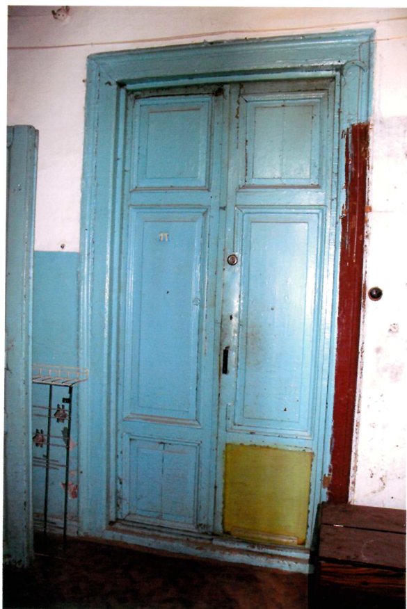
Видовая точка № 17. Прямоугольный проем для двухстворчатой двери. 1-й этаж.
