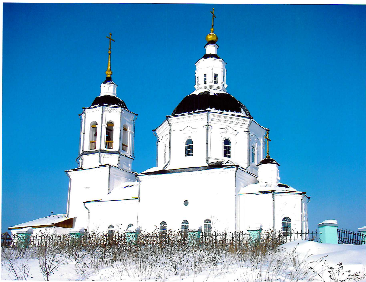
Видовая точка № 3. Южный фасад церкви. (Автор снимка: Однокопылова О.А., дата съемки: 20.02.2009 г.).
