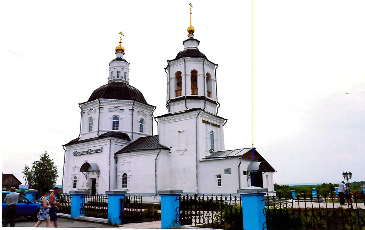
Видовая точка № 2. Общий вид церкви с северо-западной стороны (дата съемки: 26.06.2014 г.).
