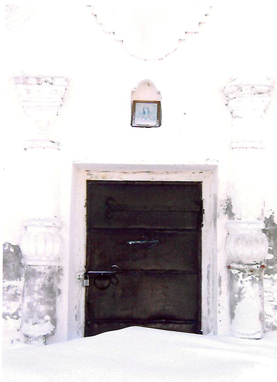
Видовая точка № 4. Оформление двери северного фасада. (Автор снимка: Яблонская М.А., дата съемки: 13.02.2006 г.).
