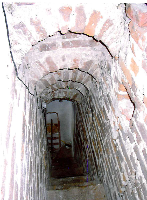
Видовая точка № 10. Лестница подъема на колокольню (в толщине стены).
