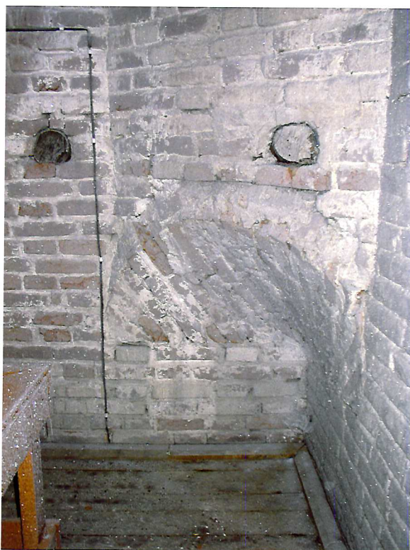
Видовая точка № 12. Свод (парус) в кирпичной кладке колокольни (место перехода с "четверика на восьмирик").
