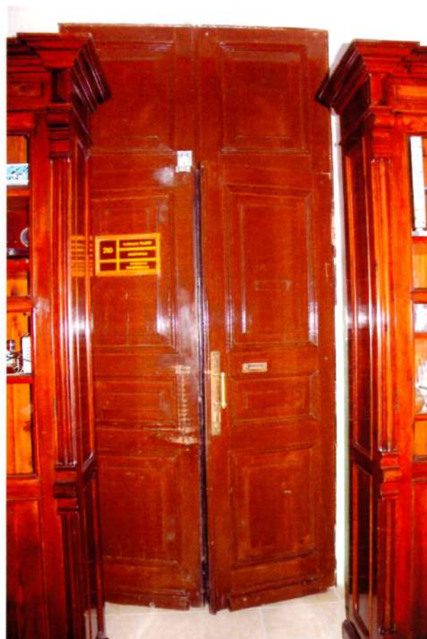
Видовая точка № 21. Деревянная филенчатая дверь с фрамугой.
