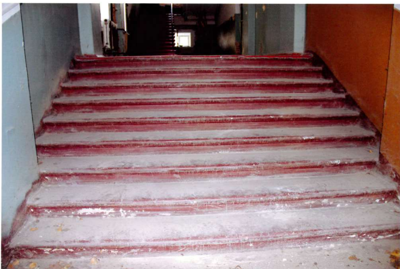
Видовая точка № 36. Парадная одномаршевая лестница из песчаника. Жилой корпус.
