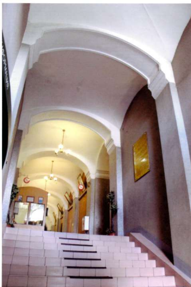
Видовая точка № 22. Входной узел учебного корпуса. Парадная одномаршевая лестница.
