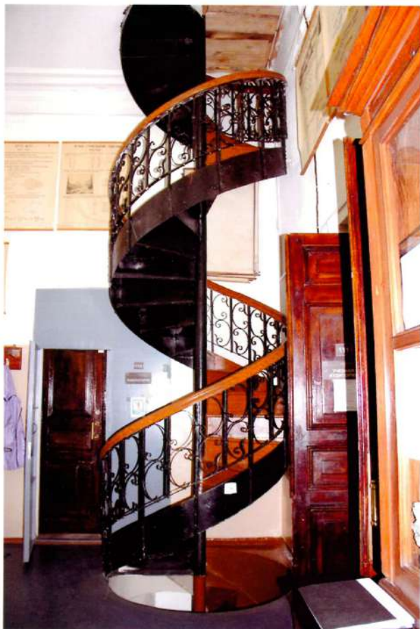
Видовая точка № 37. Металлическая винтовая лестница. Учебный корпус.
