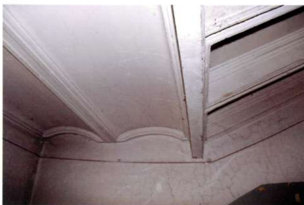
Видовая точка № 31. Своды в конструкции лестничной площадки.
