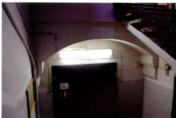
Видовая точка № 32. Своды в конструкции лестничной площадки.
