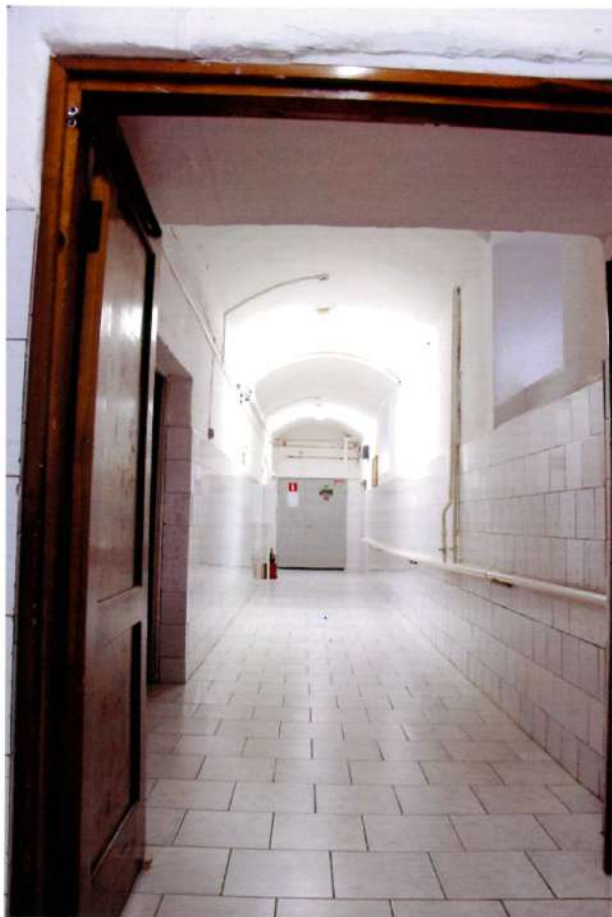
Видовая точка № 24. Фрагмент подвального этажа. Коридор. Учебный корпус.
