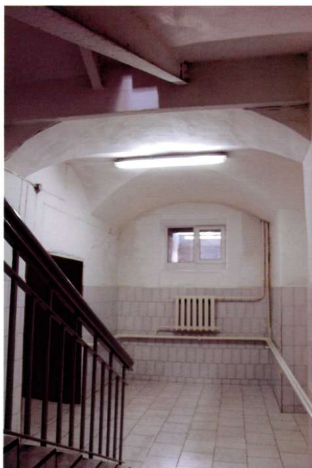
Видовая точка № 23. Фрагмент подвального этажа. Лестничный блок. Учебного корпус.
