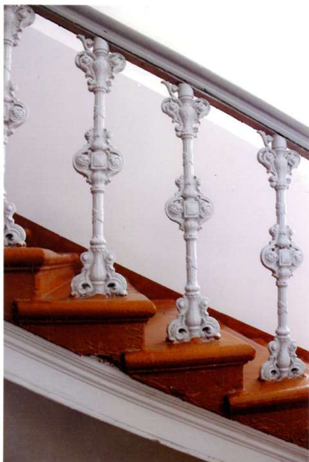
Видовая точка № 34. Ограждение лестницы (литье). Учебный корпус.
