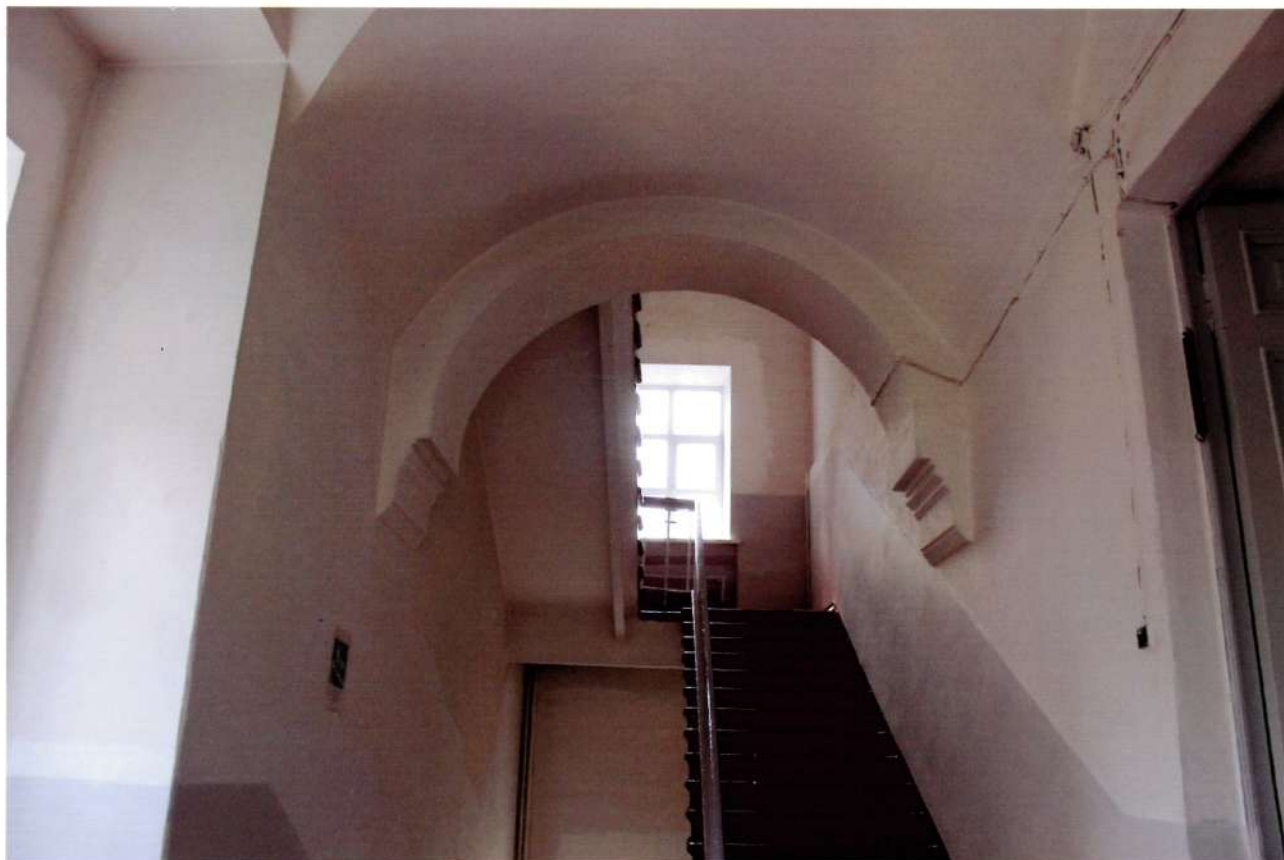
Видовая точка № 30. Лестница из песчаника. Циркулярная арка. Учебный корпус.
