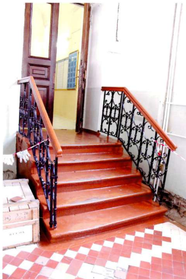
Видовая точка № 38. Небольшая лестница из песчаника с кованым ограждением. Лаборатория учебного корпуса.
