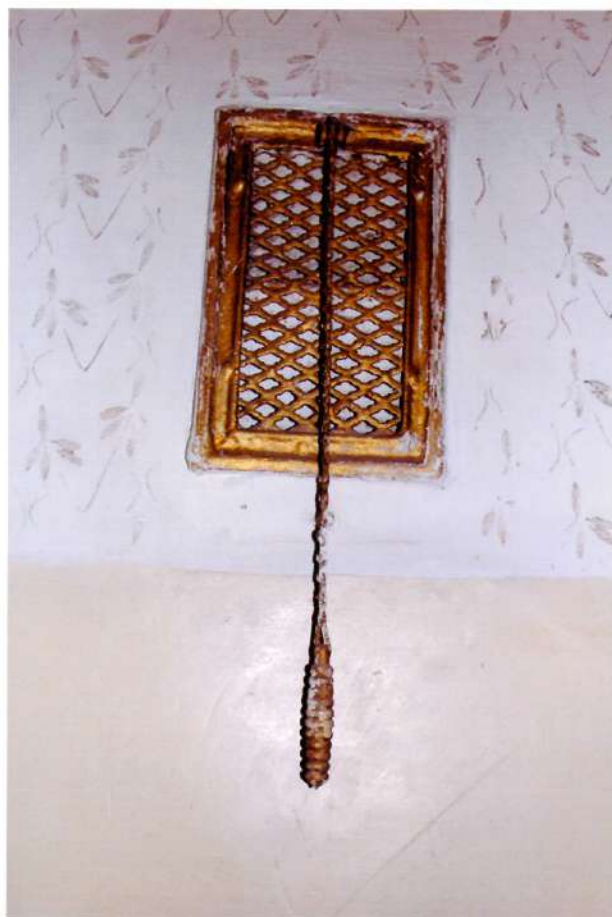
Видовая точка № 42. Вентиляционная решетка.
