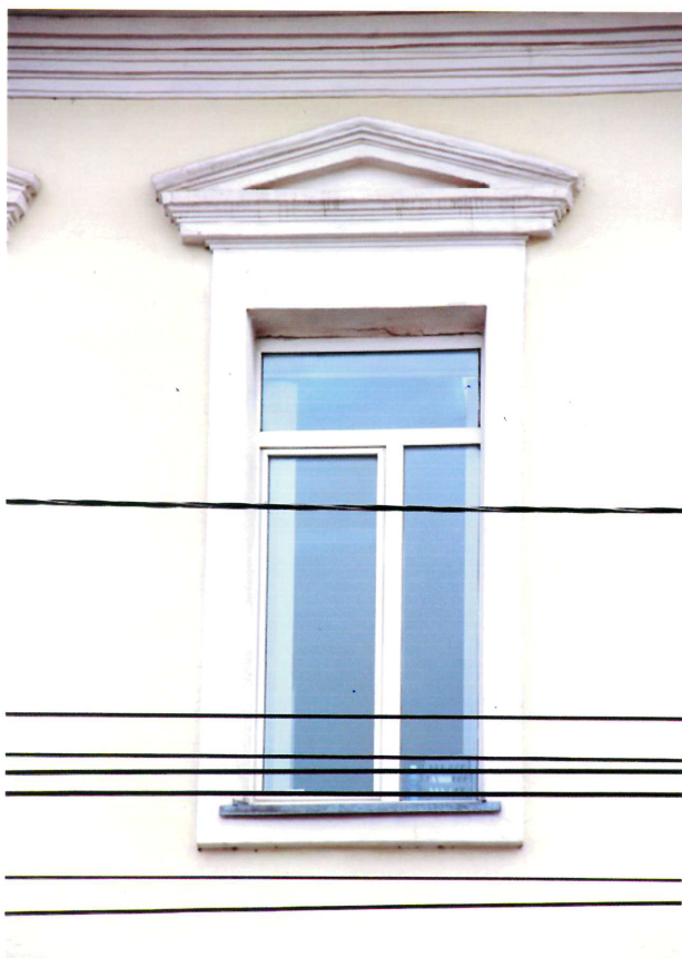
Видовая точка № 3. Декоративное обрамление окон 3-го этажа. Треугольный сандрик. Главный фасад.
