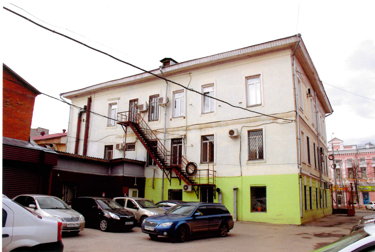
Видовая точка № 5. Дворовый (восточный) фасад здания.
