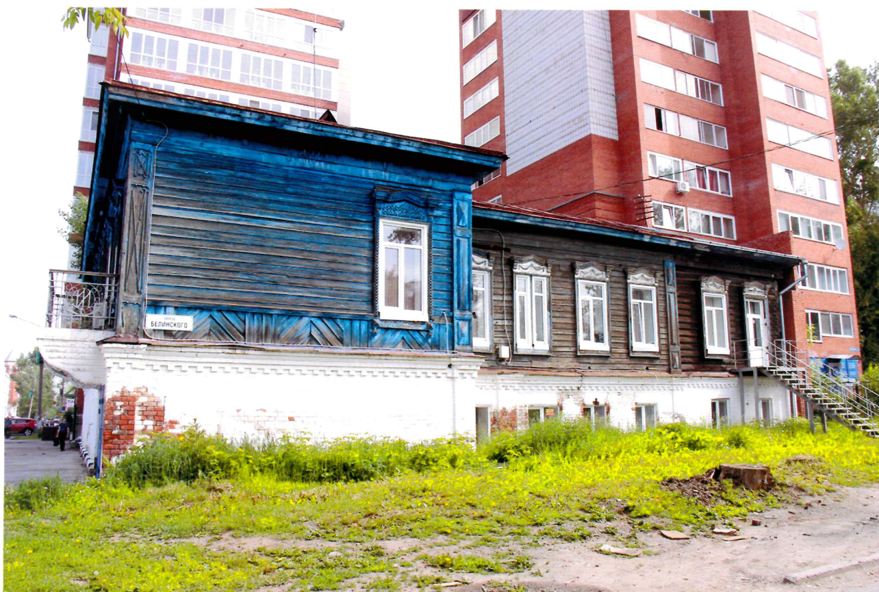
Видовая точка № 4. Южный фасад здания.
