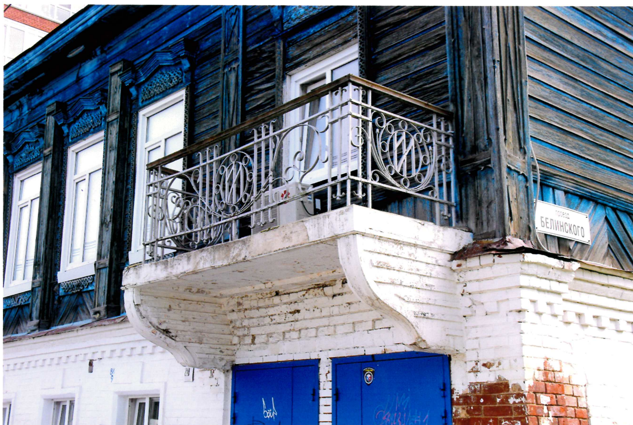
Видовая точка № 9. Балкон главного фасада.
