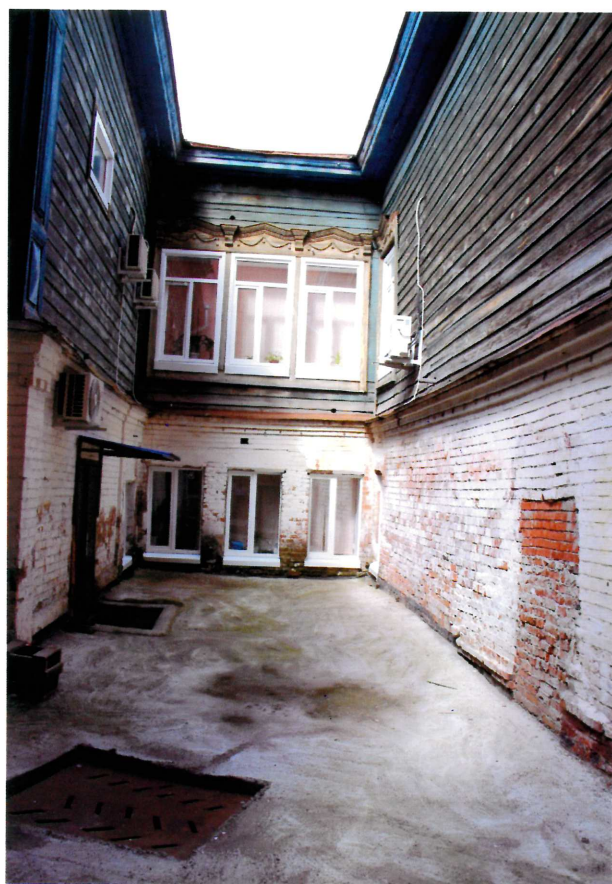
Видовая точка № 5. Центральная часть дворового (восточного) фасада.
