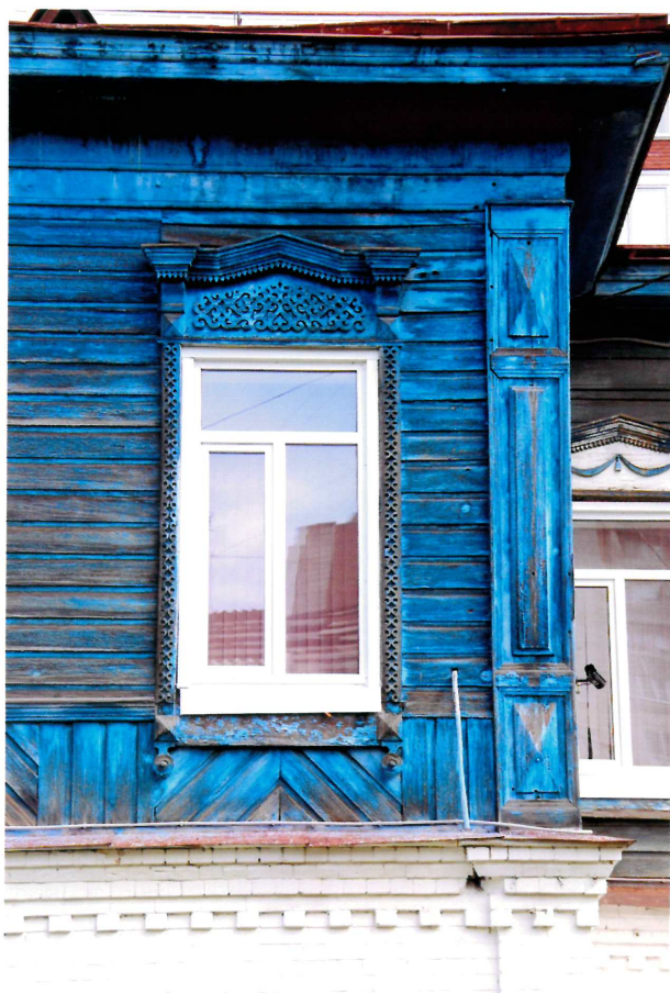
Видовая точка № 7. Окно 2-го этажа. Ризалит южного фасада. Элементы декора (обшивка, пилястра, карниз, наличник).
