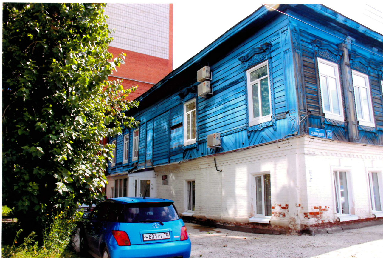
Видовая точка № 3. Северный фасад здания.
