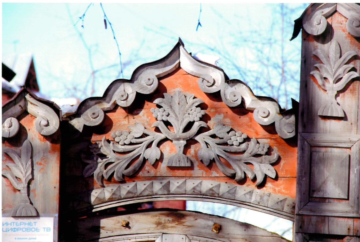
Видовая точка № 8. Перемычка над левой калиткой.
