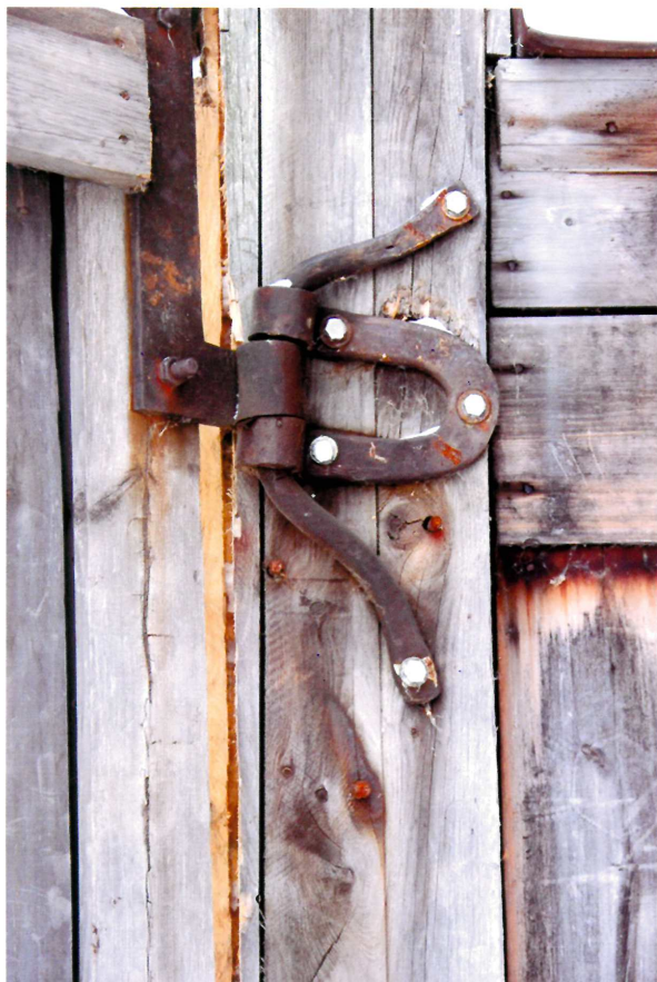
Видовая точка № 11. Кованые металлические навесы. Вид с внутри дворовой территории.
