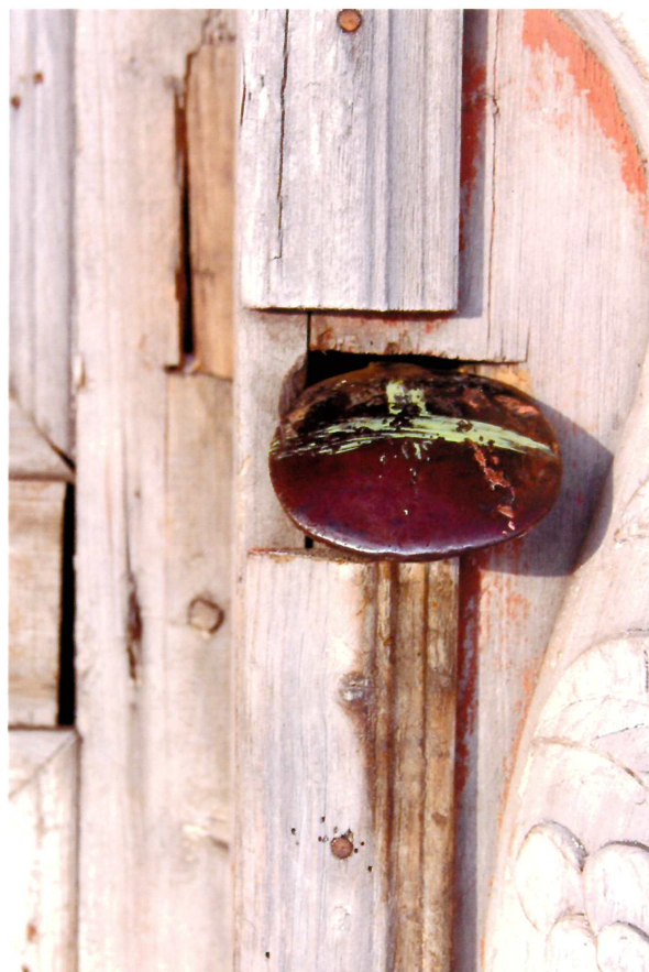
Видовая точка № 12. Запорный механизм (щеколда) левой калитки. Вид с пер. Соляного.
