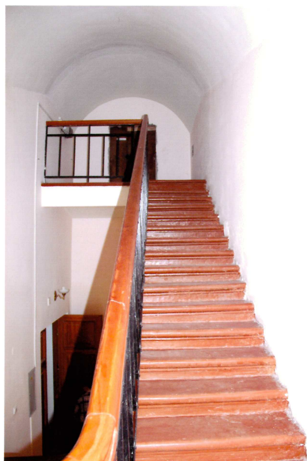
Видовая точка № 21. 2-х маршевая лестница западной части здания. Уровень 2-го этажа.
