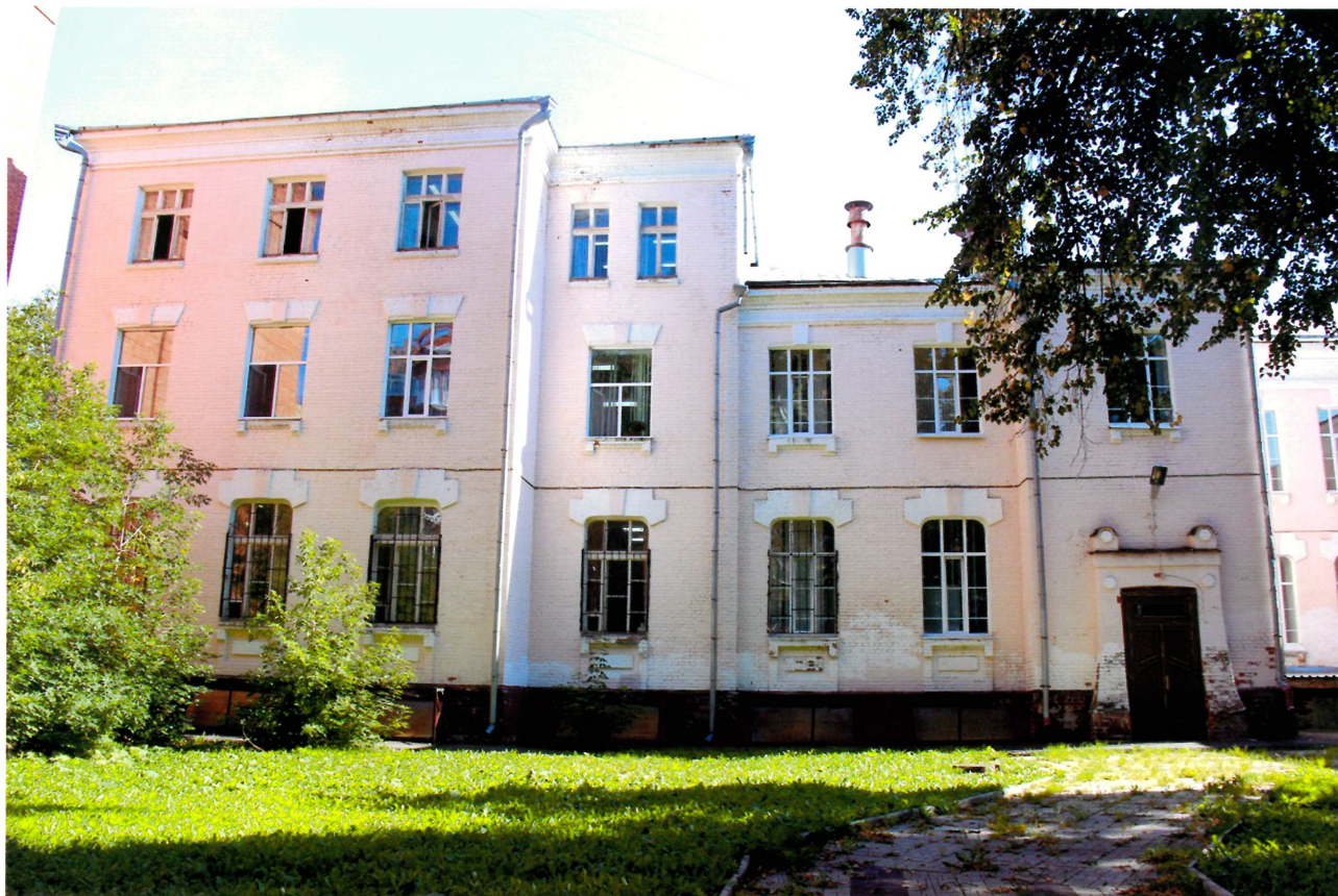
Видовая точка № 10. Дворовая часть западного фасада. Вид с внутри дворовой территории.
