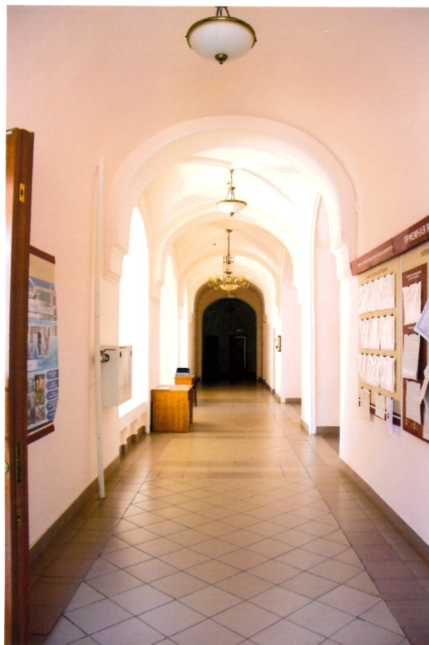
Видовая точка № 32. Коридор 1-го этажа. Угловая часть здания.
