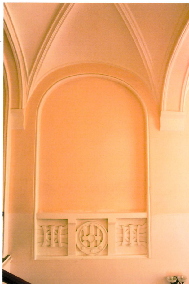
Видовая точка № 37. Ниша с арочным завершением и декоративным оформлением. Лестничный блок парадной лестницы.
