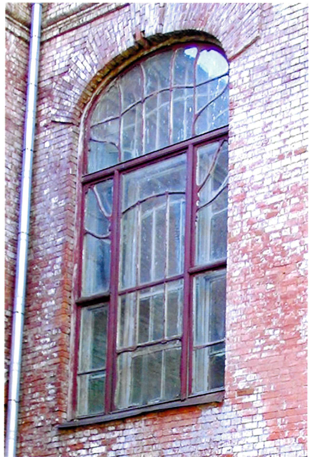
Видовая точка № 16. Арочное (полукруглое) окно ризалита и его первоначальный вид заполнения. Дворовая часть северного фасада (2001 г.).
