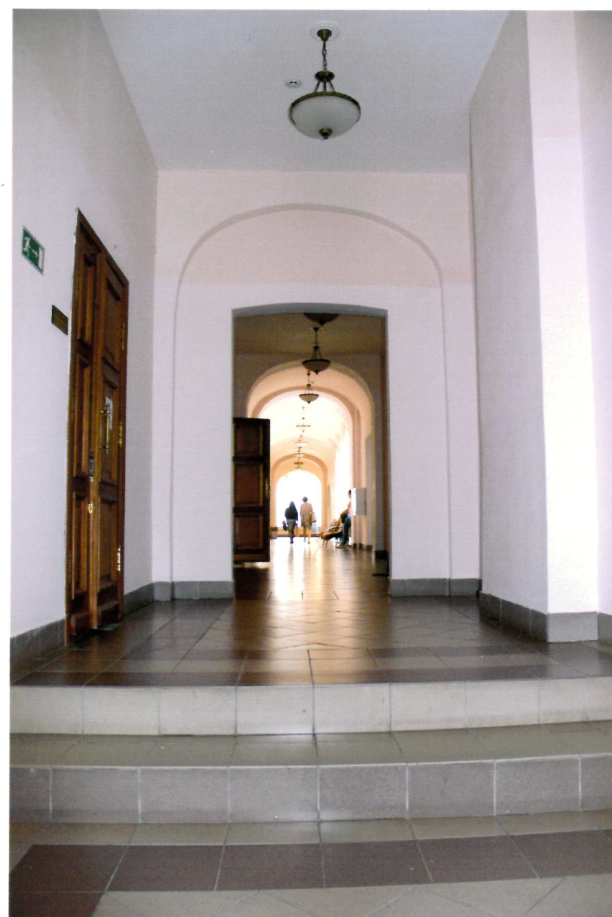
Видовая точка № 33. Коридор 1-го этажа. Дворовая часть здания.
