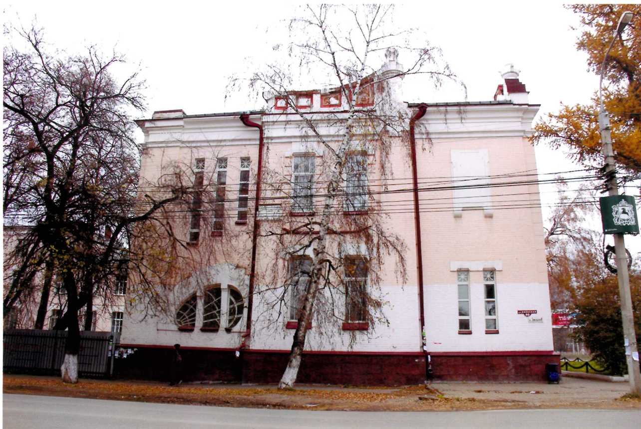
Видовая точка № 6. Торцевая часть западного фасада. Вид с ул. Киевской.
