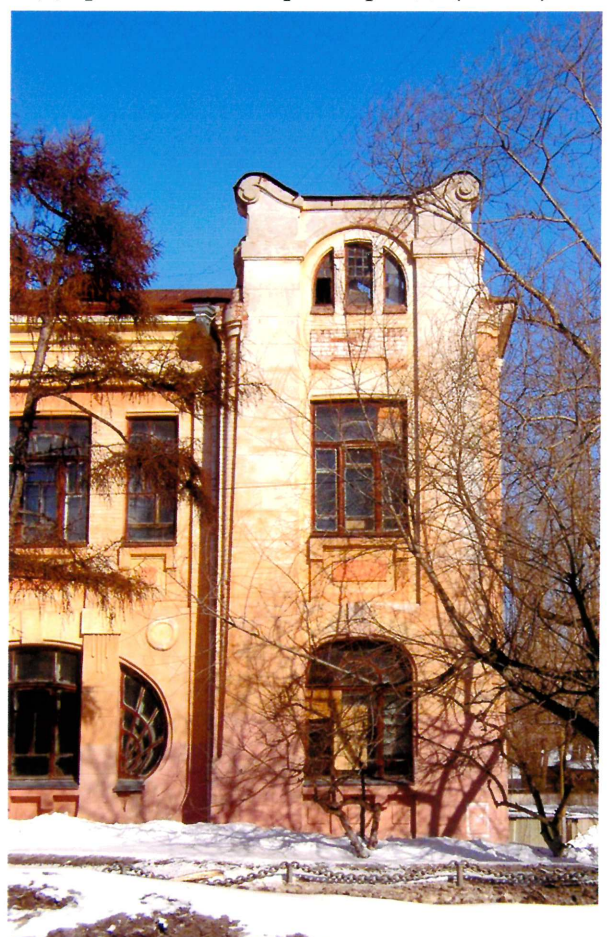
Видовая точка № 19. Ризалит главного фасада (2004 г.). Первоначальный вид оконных заполнений.
