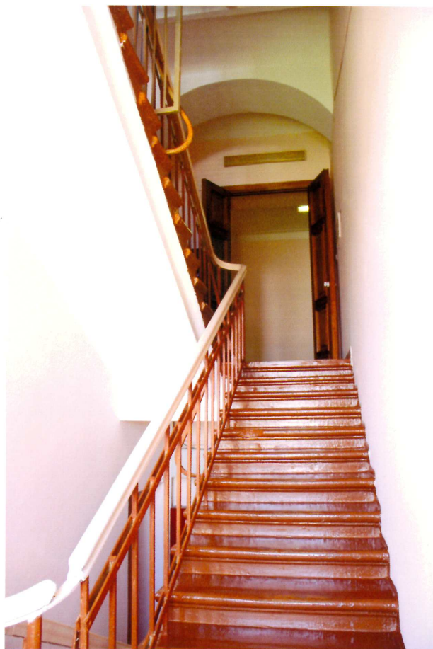
Видовая точка № 24. 2-х маршевая лестница дворовой части здания (3-х этажный объем). Уровень 3-го этажа.
