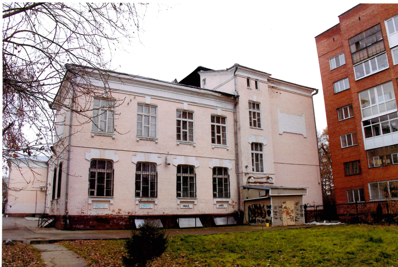
Видовая точка № 9. Торцевая часть северного фасада. Вид с дворовой территории.
