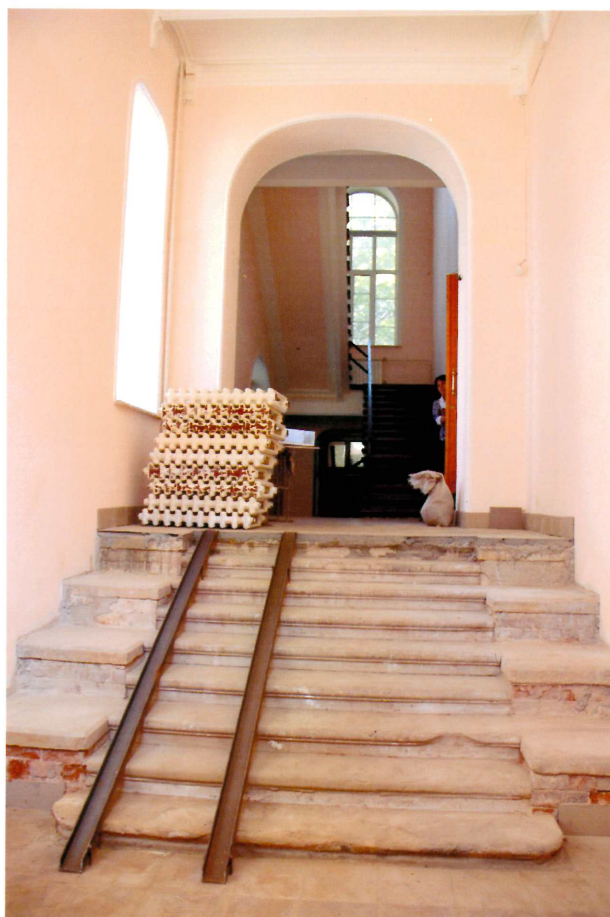
Видовая точка № 20. Одномаршевая лестница западной части здания (торец). Первый этаж.
