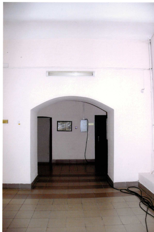
Видовая точка № 30. Лучковый проем. Уровень подвала.
