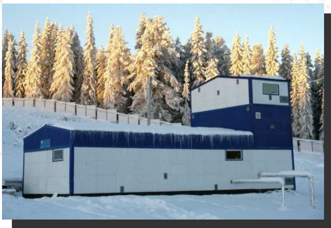
Блок-бокс для размещения водоочистного комплекса «Импульс»
